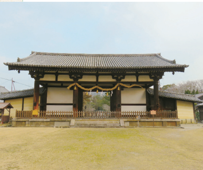
国宝 転害門／三間一戸八脚門の形式をもつ堂々とした門で、天平時代の東大寺の伽藍建築を想像できる唯一の遺構である。
